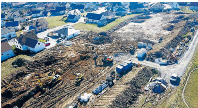
In der Drohnenaufnahme ist der aktuelle Baufortschritt zu sehen
